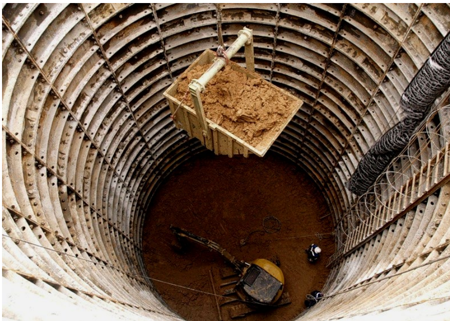
Рис. 3.1. Строительство шахтного ствола
