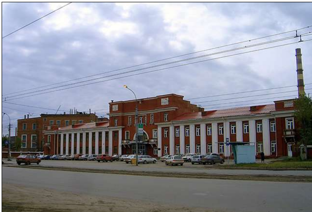
Рисунок 3 – Промышленное здание Новосибирский оловянный комбинат ОАО «НОК»
