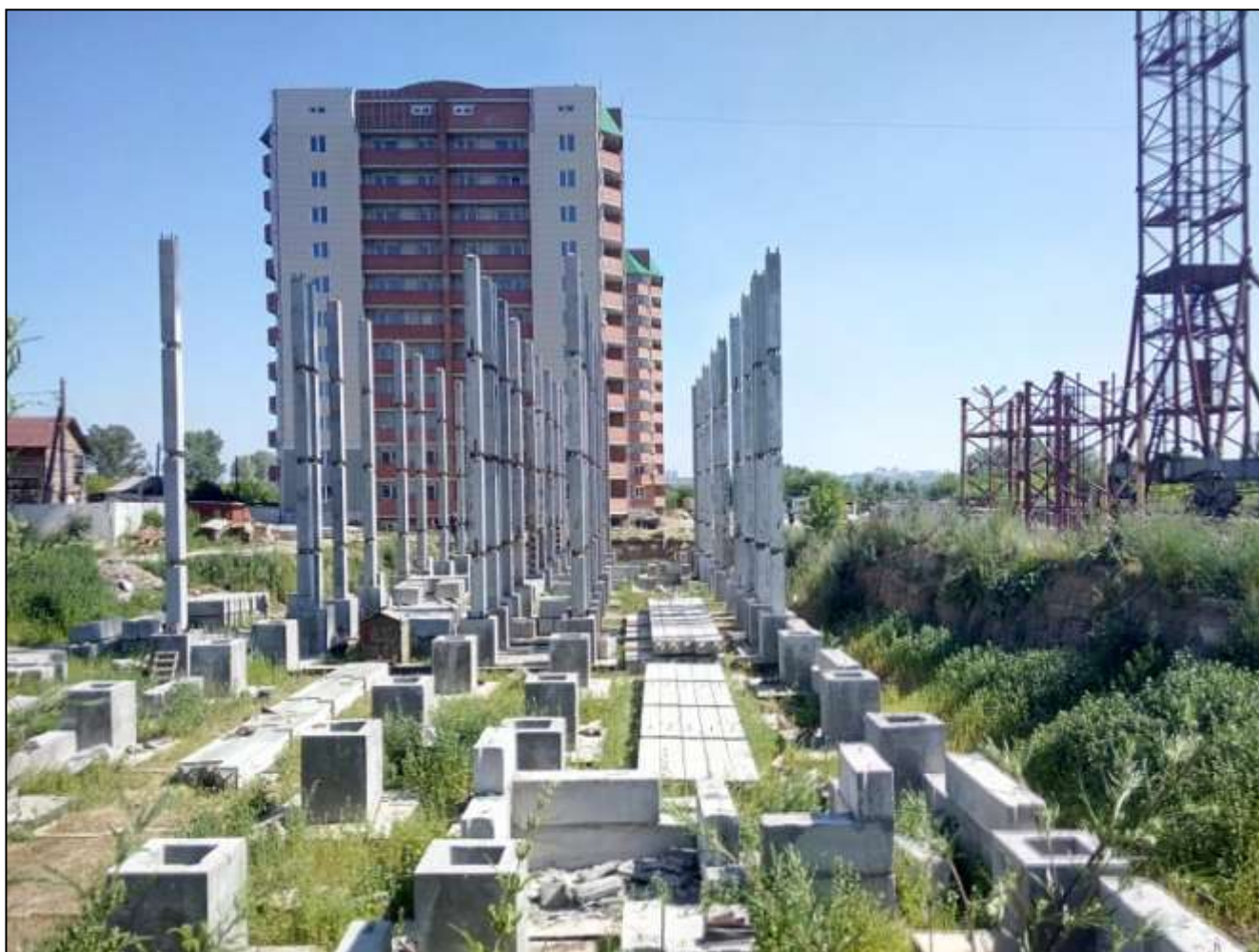
Рисунок 14 – Проверка вертикальности колонн в створе на строительной площадке по ул. Герцена ½ г. Новосибирск
