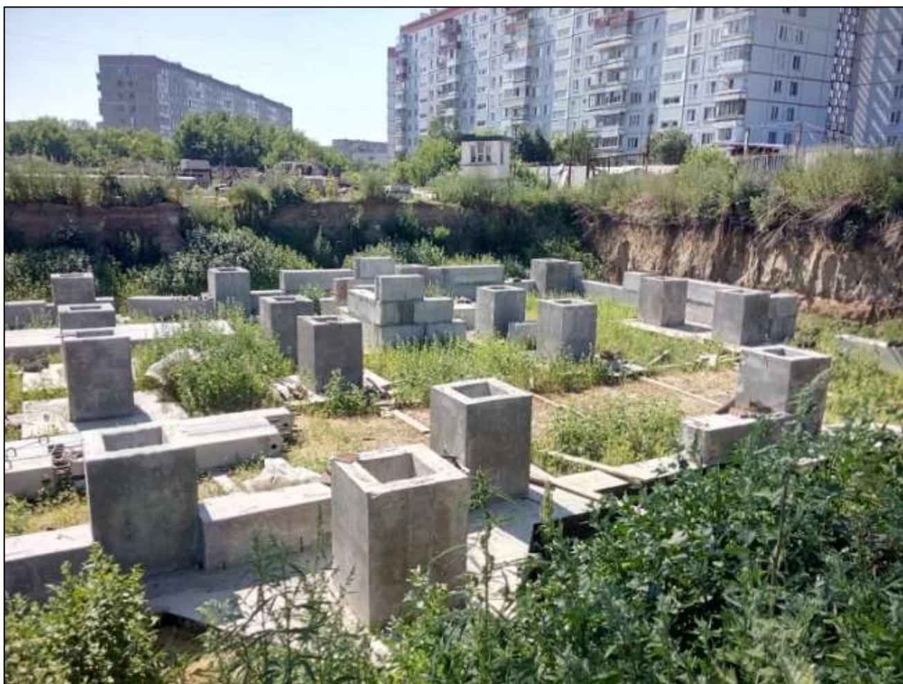
Рисунок 12 – Фундамент с бетонными стаканами под железобетонные колонны
