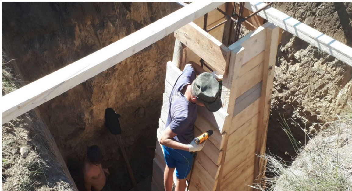
Рис. 9. Закладка основного центра ФАГС в пос. Онгудай, АО «Инжгеодезия»
